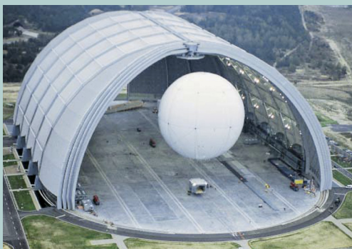
Aushallen des CL-75 AirCrane
