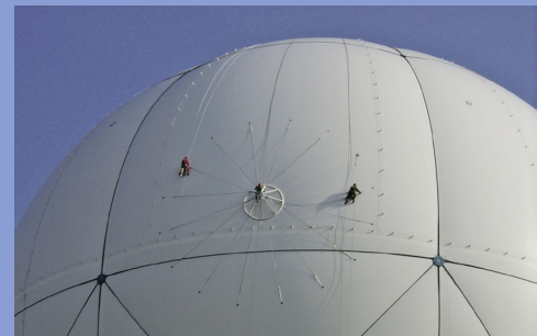
Arbeiten am Blitzschutzsystem des CL-75
