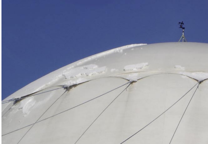
„Schneekoppe“ auf dem Ballon – als die gesamte Kuppe noch bedeckt war, lagen auf dem 18m-Ballon mehrere hundert kg Schnee
