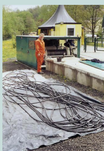
Bilder links und oben: Seilwechsel am Vogtlandballon
